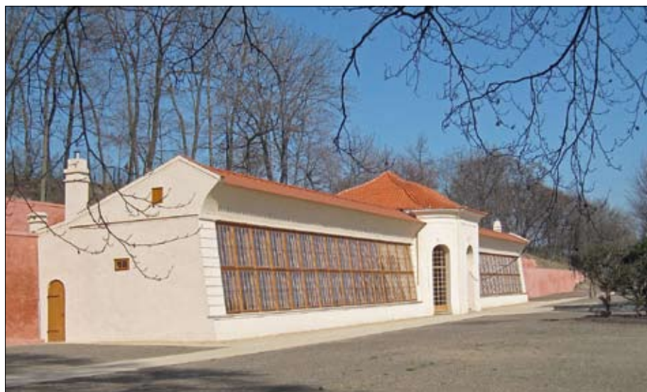
Obr. 43: Zdařilou součinnost stavebně historického průzkumu, archeologického výzkumu, operační dokumentace stavebních konstrukcí a projektu obnovy lze dokumentovat na příkladu obnovy oranžerie v zahradě Břevoňského kláštera. Z původní stavby zůstaly zachovány pouze obvodové zdi, a přesto se jí podařilo obnovit. (Foto D. Fetterová, 2012)
