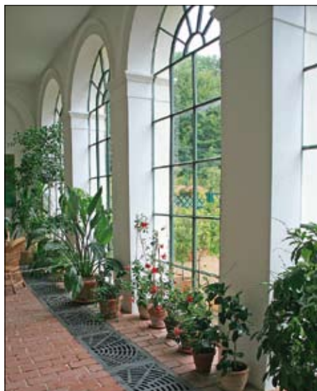
Obr. 33: Okrasná litinová mřížovina, kryjící kanálové topení – Raduň. (Foto E. Choosta, 2009)
