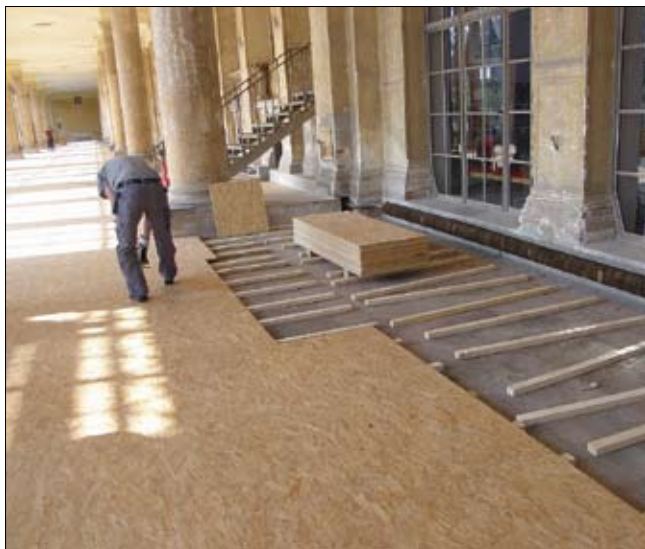
Obr. 52: Instalace jednoduché dřevěné podlahy umožňuje bezproblémový letní provoz velké oranžerie v Sanssouci. V zimě jsou zde umístěny rostliny. (Foto L. Křesadlová, 2009)
