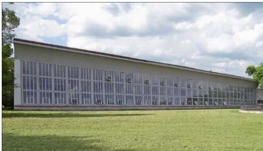
Obr. 26: Zadní, zděná strana této oranžerie tvoří Point de vue hlavní kompoziční osy barokní zahrady v Dobříši. (Foto J. Válek, 2012)
