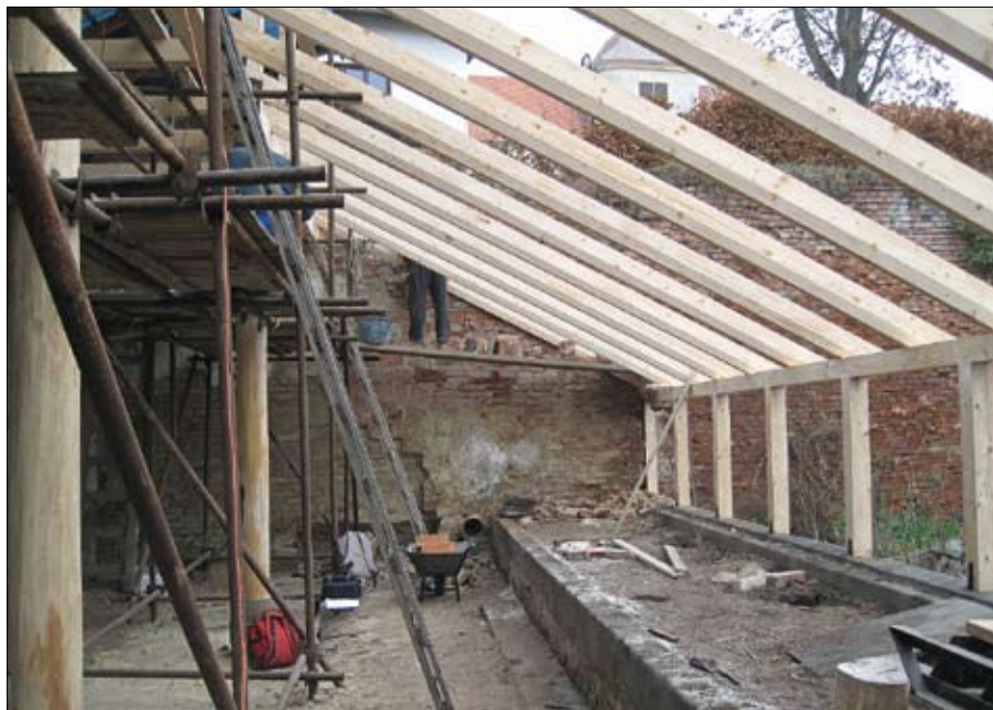
Obr. 55: Obnova čelní prosklené stěny a stropu. (Foto D. Fetterová, 2011)
