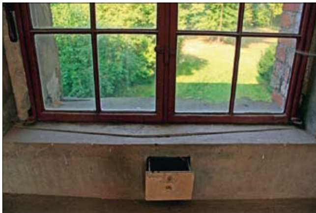
Obr. 42: Kanálek a nádoba na zachycení vody kondenzující na sklech ve Velké oranžerii v Sanssouci. (Foto E. Choosta, 2009)
