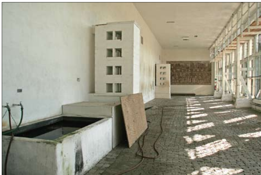
Obr. 30: Vytápění zděnými kamny s průduchy a nádrž na ohřev zálikové vody v Oranienbaum. (Foto E. Choosta, 2009)
