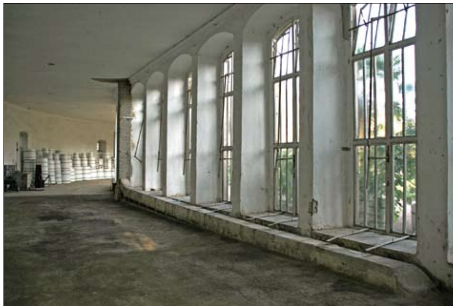
Obr. 31: Pozvolna stoupající zděný spalinový kanál, výjimečně se vstupem do komína na přední stěně v oranžerii Wiemar – Belveder. (Foto E. Choosta, 2009)
