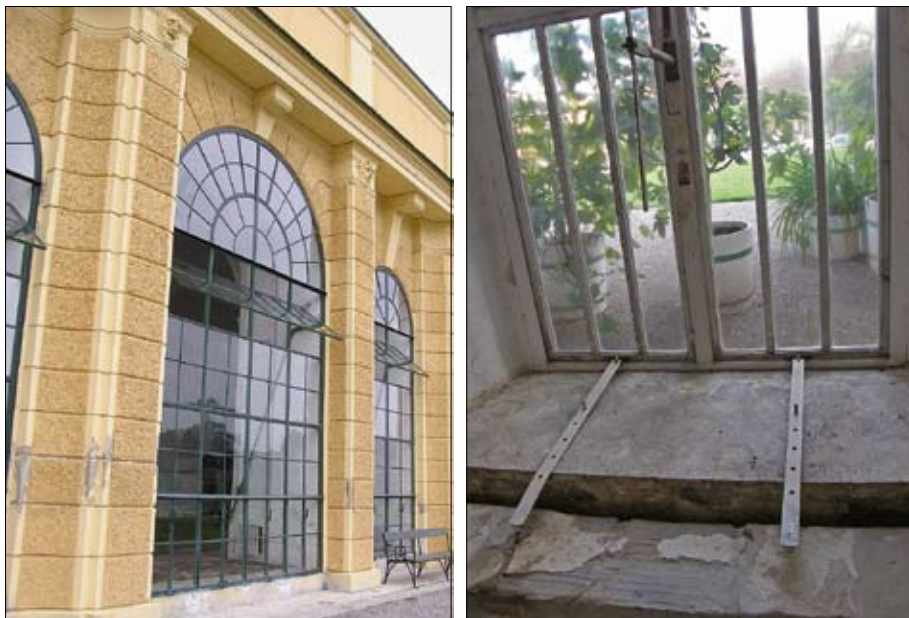
Obr. 40: Dva různé systémy otevírání oken – vyklápění oken pomocí převodů (olevo), vyklápění pomocí děrovaných železných pásků (opravo). (Foto L. Křesadlová, 2009)
