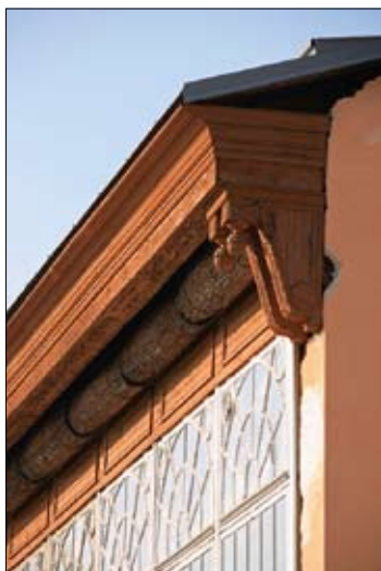
Obr. 36: Svinovací izolační rákosová rohož a její mechanismus navíjení umístěný na půdě oranžerie v Lysicích. (Foto E. Choosta, 2011).
