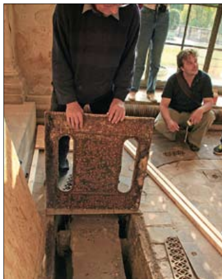
Obr. 32: Dvoupláškový horkovzdušný kanálový systém ve Velká oranžerii v Sanssouci. (Foto J. Olšan, 2009)
