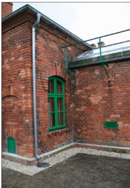
Obr. 38: V zadní stěně staoby se nacházejí příkladací doírka topeniště a vpravo mřížka větracího kanálku. Radkov – Dubová. (Foto E. Choosta, 2009)
