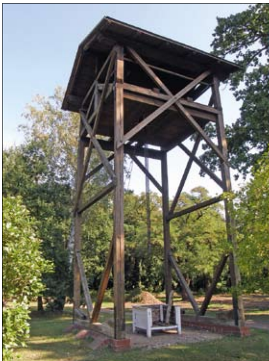
Obr. 24: U velkých oranžerií bývaly zřízeny speciální věžové stavby pro přesazování vzrostlých rostlin – Oranienbaum. (Foto L. Křesadlová 2009)
